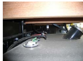
車両燃料タンクから電磁ポンプにより発電機へ自動供給（改造）
